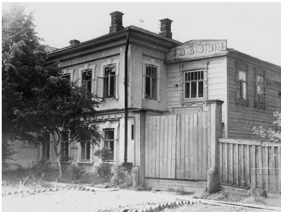
Бывшее здание МарНИИ на ул. Горького, 9
