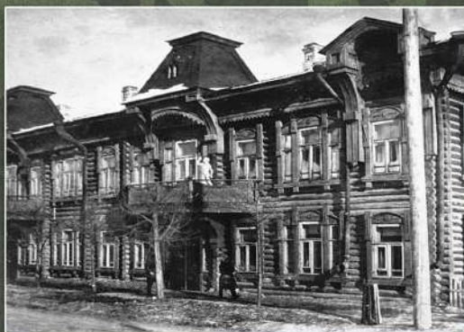
Общий вид здания Дома пионеров г. Йошкар-Олы, в котором было размещено Особое конструкторское бюро №43, эвакуированное из г. Ленинграда. Конец 1940-х гг.
