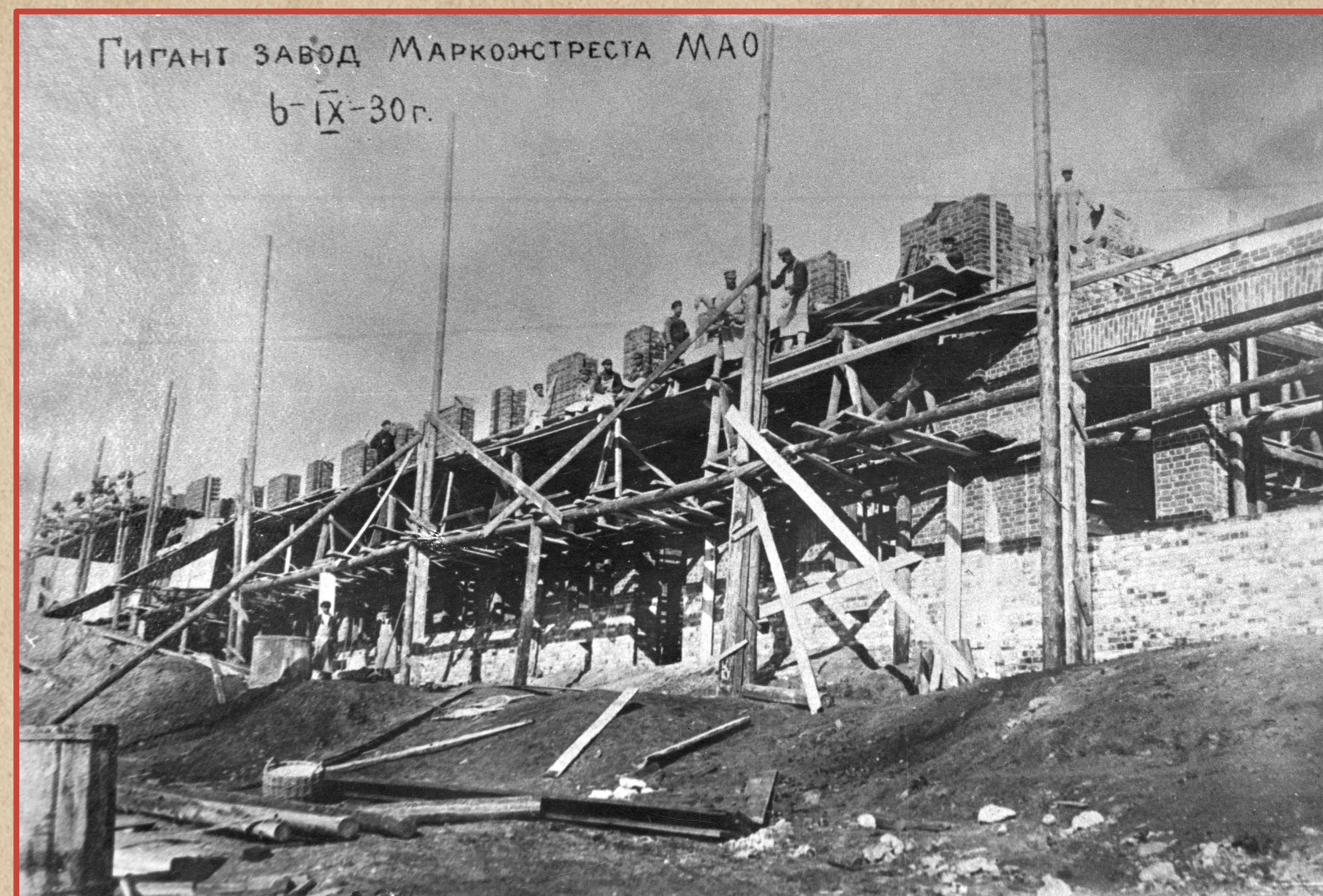
Общий вид строительства завода Марийского кожевенного треста в р.п. Юрино Юринского кантона. 1930 г.
